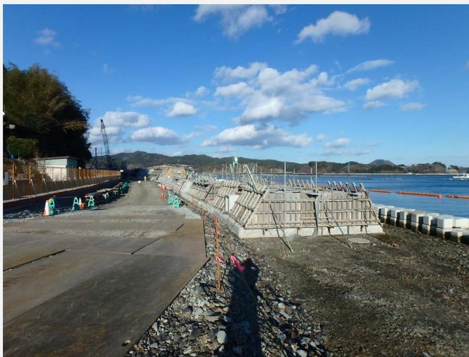
現在、護岸工のコンクリート打設を進めています。(北側)
