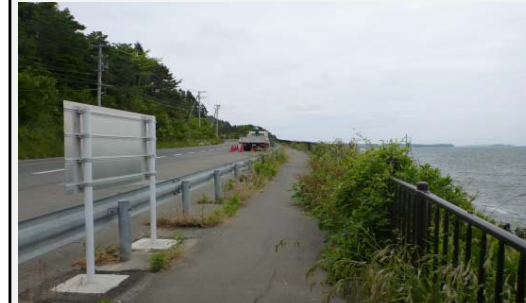
④ 着手前 平成25年10月
