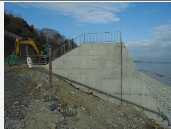
護岸擁壁工を整備中です
