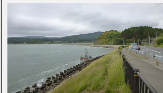
② 着手前 平成25年10月
