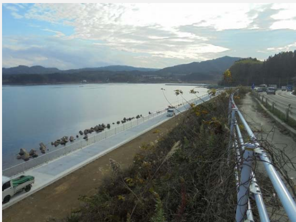
護岸擁壁工を整備中です
