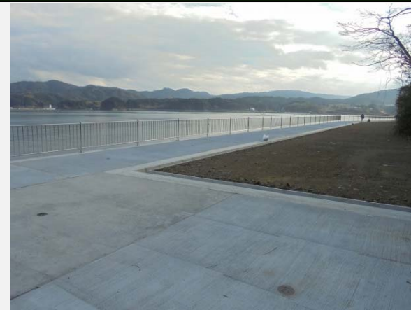
護岸擁壁工を整備中です
