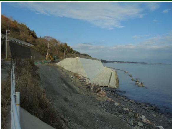
護岸擁壁工整備中です
