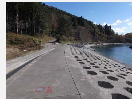
④ 着手前 平成25年10月
