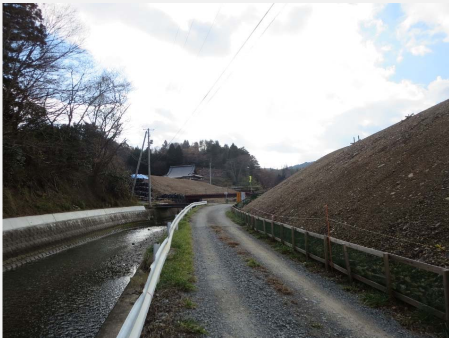
築堤を施工しています。
