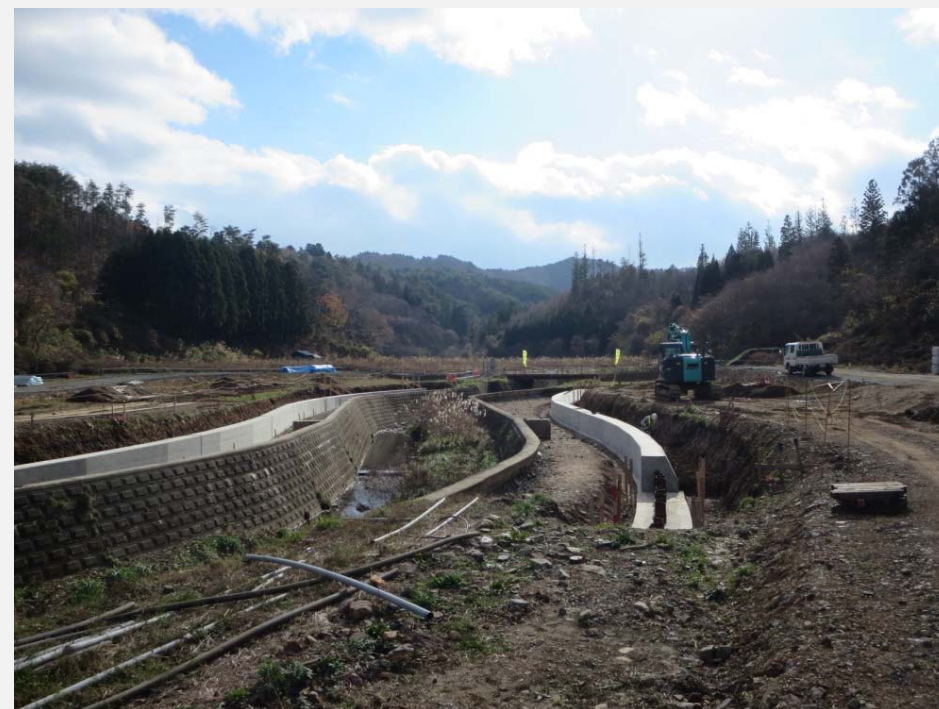
護岸基礎工を施工しています。
