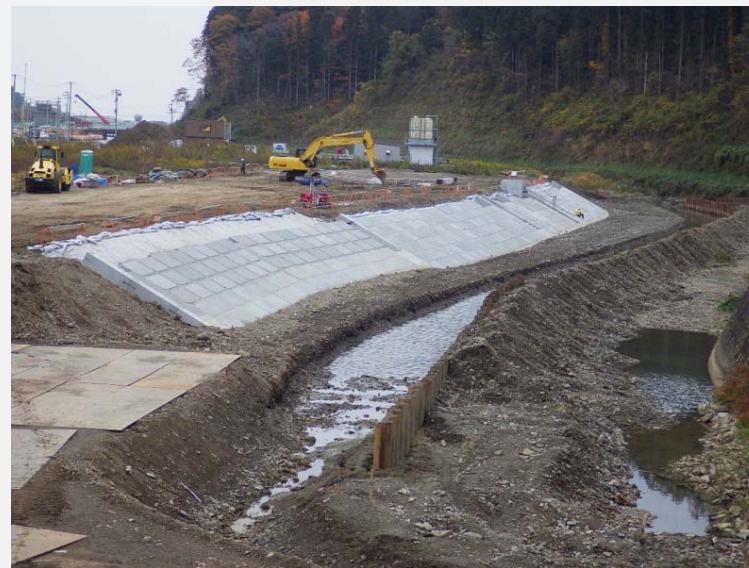
【法覆護岸工】左岸上流側 コンクリートブロック施工状況。
