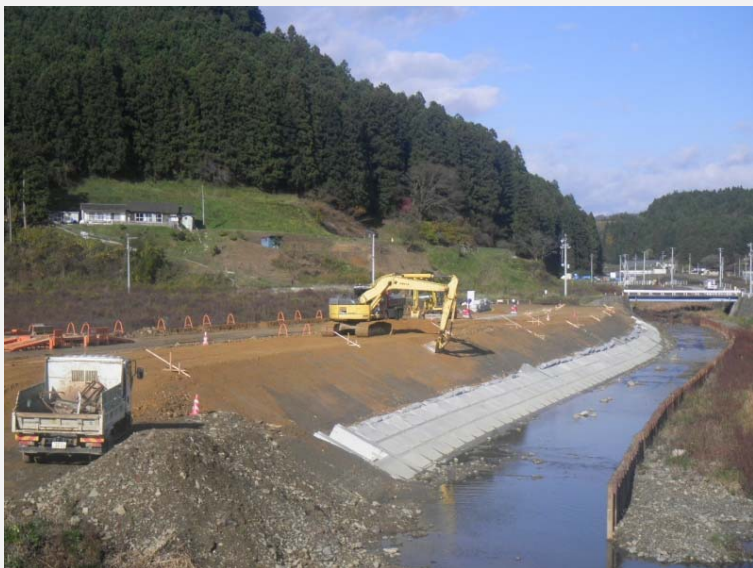
【法覆護岸工】右岸上流側 築堤盛土部施工状況
