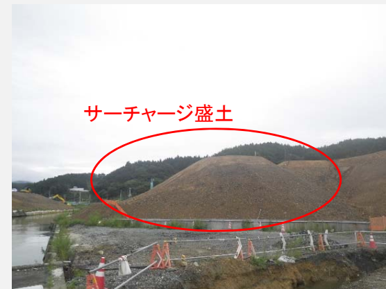
新井田1工区左岸:サーチャージ中
