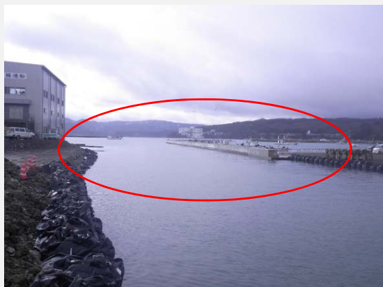
新井田水門:水門解体完了
