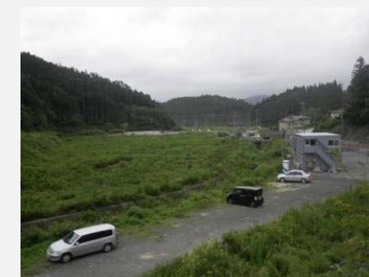
④ 着手前 平成26年8月
