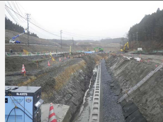
新井田3工区:護岸基礎工
