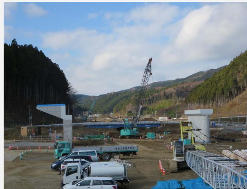
右岸橋台と橋脚を施工しています。
