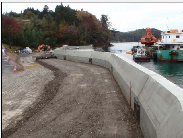
裏埋工状況 (中央部)
