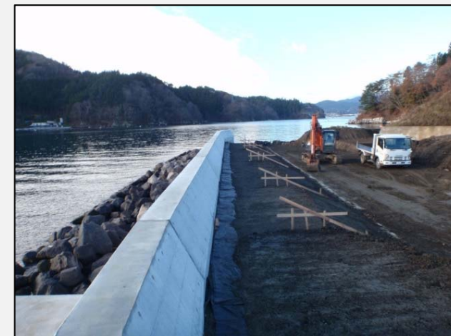
裏埋工状況 (中央部)
