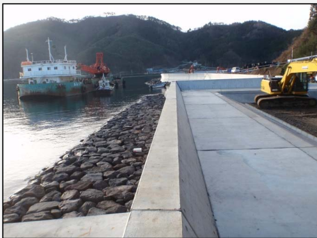
護岸工状況 (北側)
