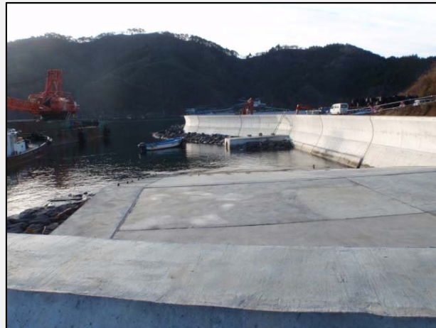
斜路工状況 (北側)
