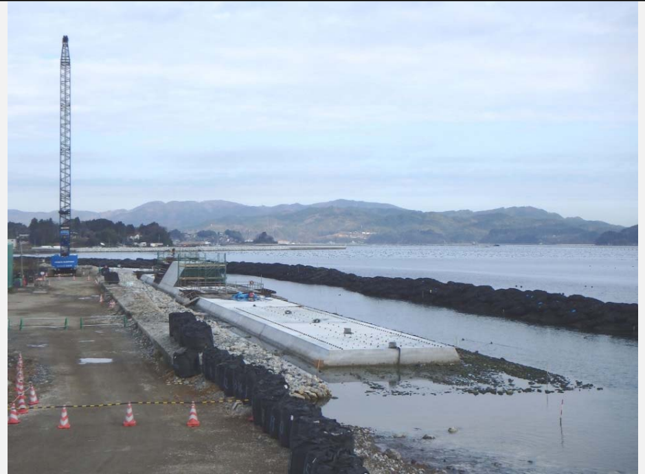
現在、コンクリート打設の作業を進めています。(南側)
