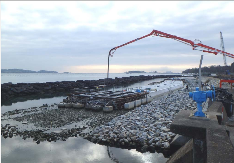
現在、コンクリート打設の作業を進めています。(北側)
