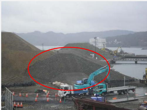
八幡2工区：1次盛土完了、プレロード中
