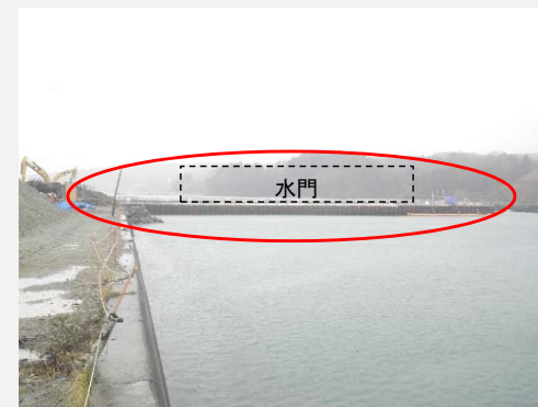
八幡水門：底版解体完了
