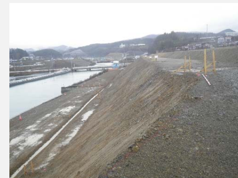
八幡3工区：プレロード盛土掘削
