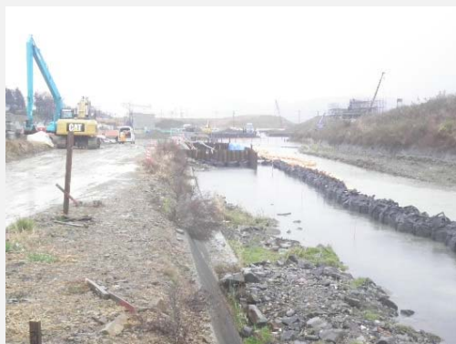
八幡4工区：一部仮締切、床掘り
