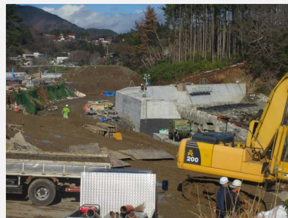
型枠設置状況
