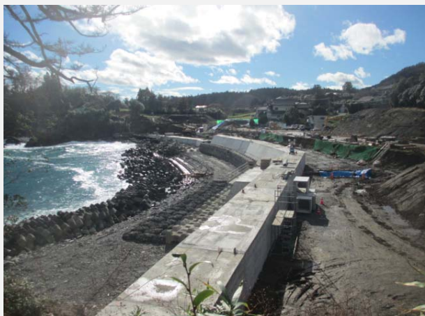
生コン打設状況
