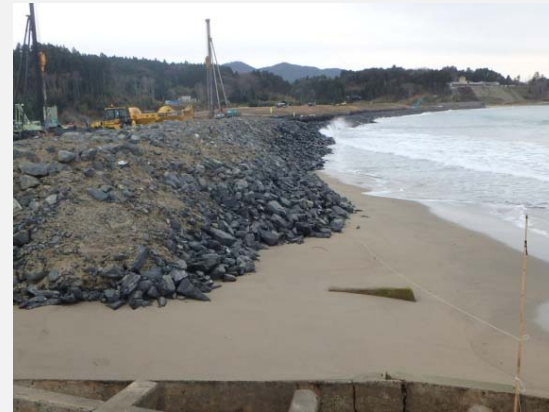
シーサイドパレス解体(完了)と仮設道路の設置を行っています。
