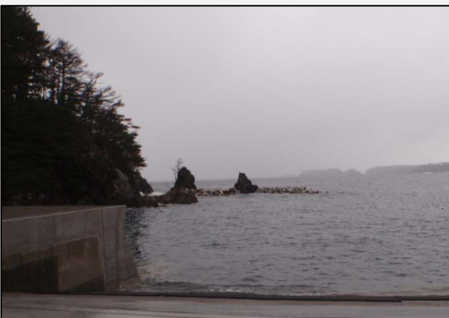
離岸堤施工 状況(南側)
