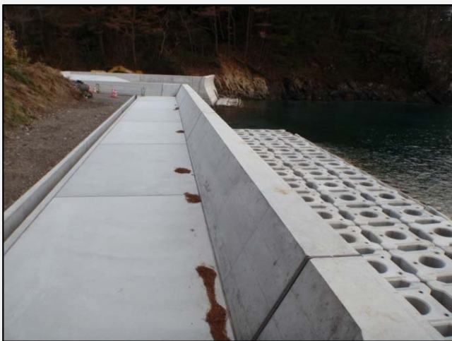
護岸工施工 状況(西側)
