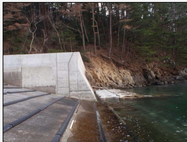
護岸工施工 状況(東側)
